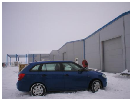
Objekt skladov v Rovinke
